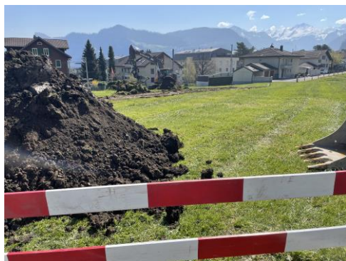
Baustelle Pumptrack in der Matt
